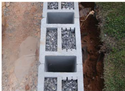
Figura 39 - Drenagem através das cavidades do Geobloco H
