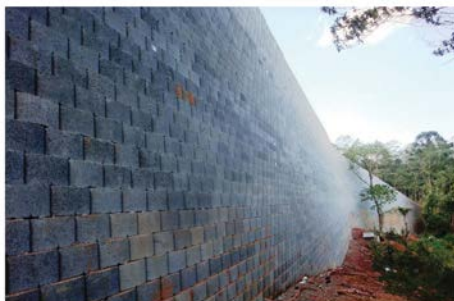
Figura 40 - Face com blocos segmentais Geobloco H – em muro de solo reforçado.
