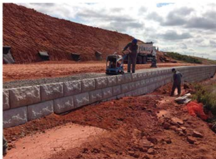
Figura 64 - Compactação da camada de brita do aterro
