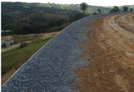
Figura 61 Preenchimento dos contraforte com brita
