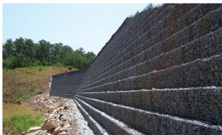
Figura 41 - Estrutura de solo reforçado com face Strata Slope e preenchido com material granular
