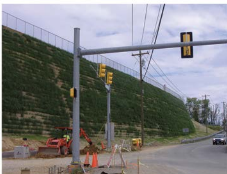
Figura 42 - Face em Strata Slope vegetada de uma estrutura de solo reforçado
