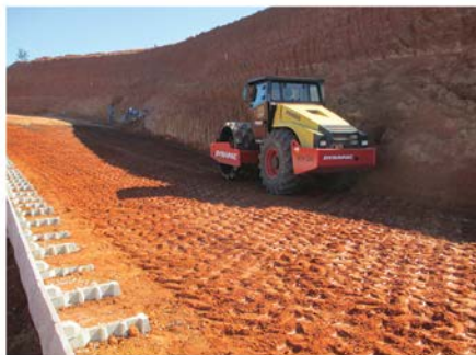
Figura 65 - Compactação junto à face
