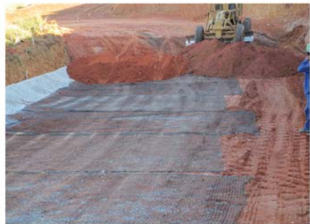
Figura 62 - Colocação da geogrelha e execução do aterro de solo
