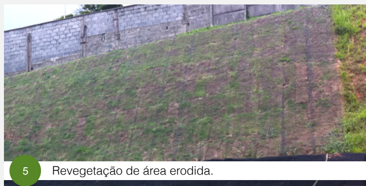
4 Recomposição de talude.
